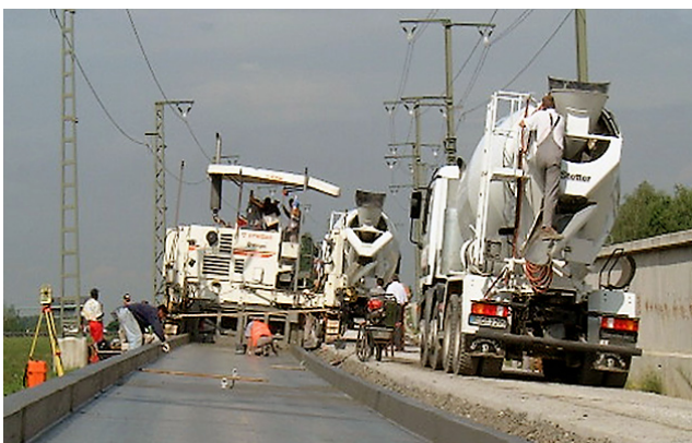
Abb. 1: Pilotprojekte: 3D-Steuerung eines Gleitschalungsfertigers an der ICE-Neubaustrecke zwischen Frankfurt-Köln, 1999 (links) und 3D-Steuerung eines Asphaltfertigers während der Autobahnsanierung St. Gallen/Schweiz, 2000 (rechts)
