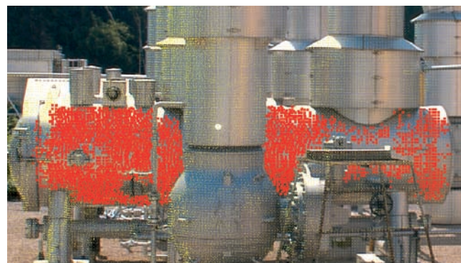
Abb. 7: Automatisch aggregierte Zylinderflächenpunkte
