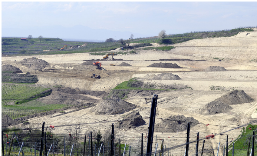
Abb. 10: Neuterrassierung im Rahmen einer Rebflurbereinigung am Kaiserstuhl
