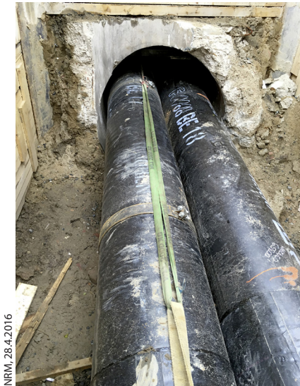
Abb. 8: Fertigstellung des Rohreinzugs noch ohne Betonverfüllung
