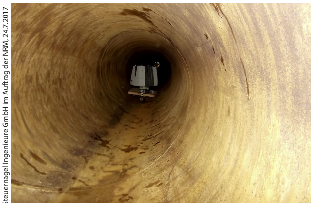
Abb. 11: Mantelrohr unterhalb DB-Trasse, 3D-Scanning-Objekt
