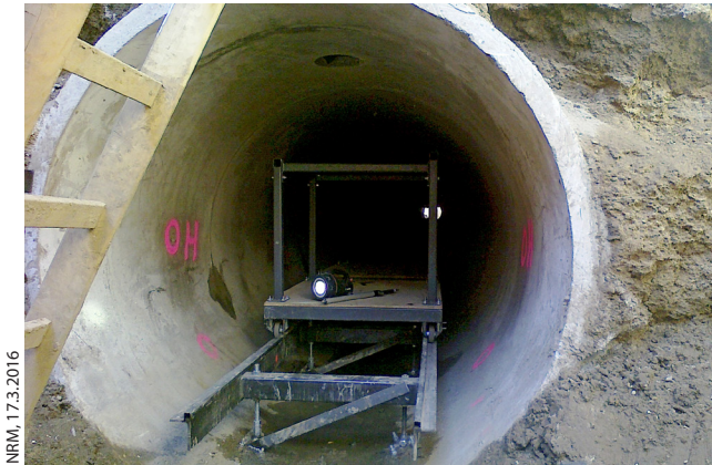
Abb. 7: Freigelegter ehemaliger Kühlwasserkanal und Schienensystem
