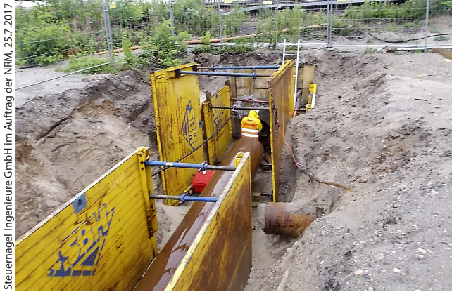
Abb. 10: Mantelrohr unterhalb DB-Trasse, 3D-Scanning-Objekt
